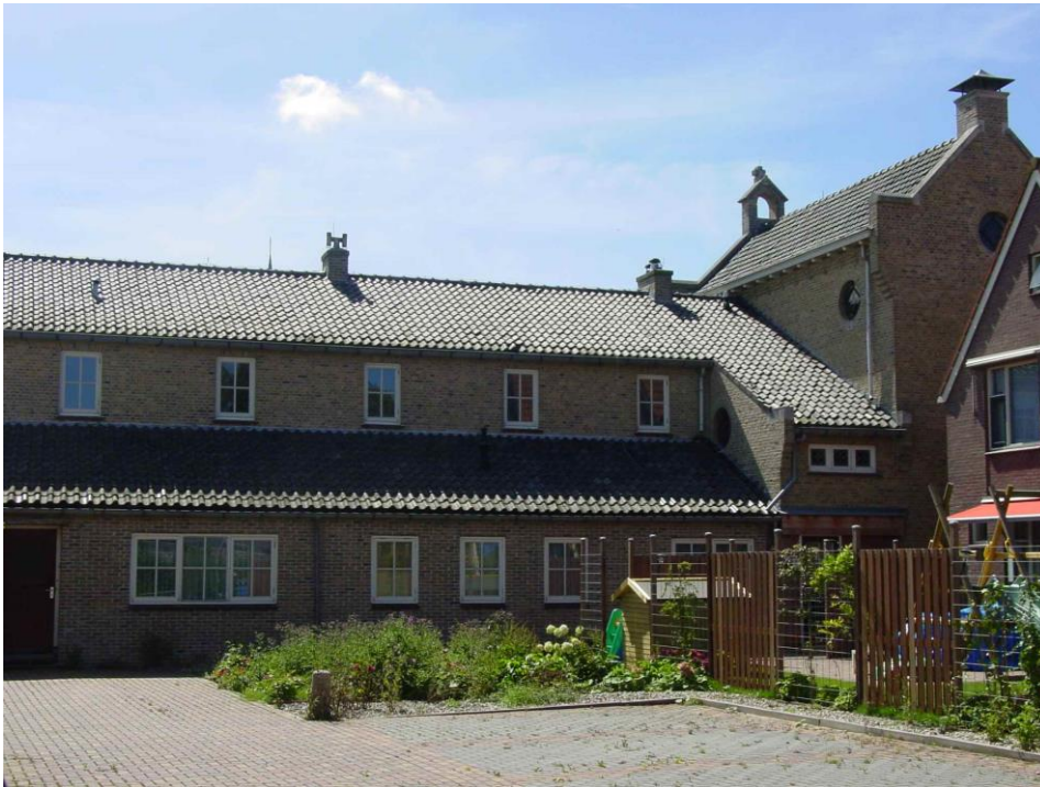
Afb. 13. De linkerzijgevel met op de begane grond de aanbouw met lessenaardak uit 1961 (foto d.d. 16-8-2004; vergelijk met afb. 9 voor de oorspronkelijke situatie).
