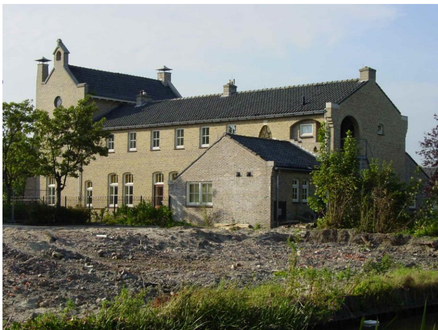
Afb. 12. Maria-oord gezien vanuit het zuiden. De lage uitbouw is het in 1961 vergrote washuis. Erboven de twee bogen van het overdekte terras dat in 1957 verkleind werd voor de bouw van een badkamer met douche (foto d.d. 24-7-2004; vergelijk met afb. 8 voor de oorspronkelijke situatie).
