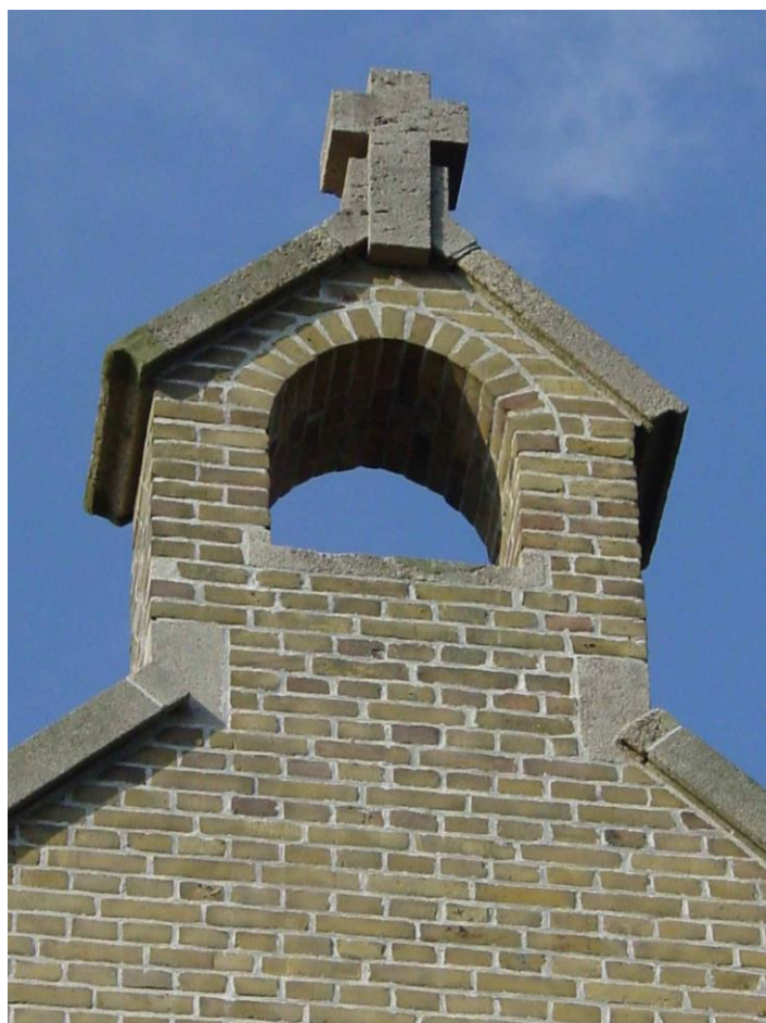
Afb. 11. Detail rechterzijgevel. Tot de zomer van 1943 hing hier het angelusklokje (foto d.d. 24-7-2004).
