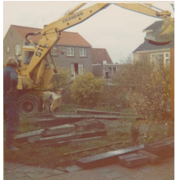
Sloop van de sluis 1976.
