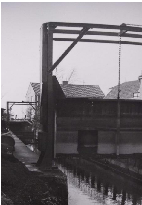
Figuur 36 foto sluis fam. Potveer
