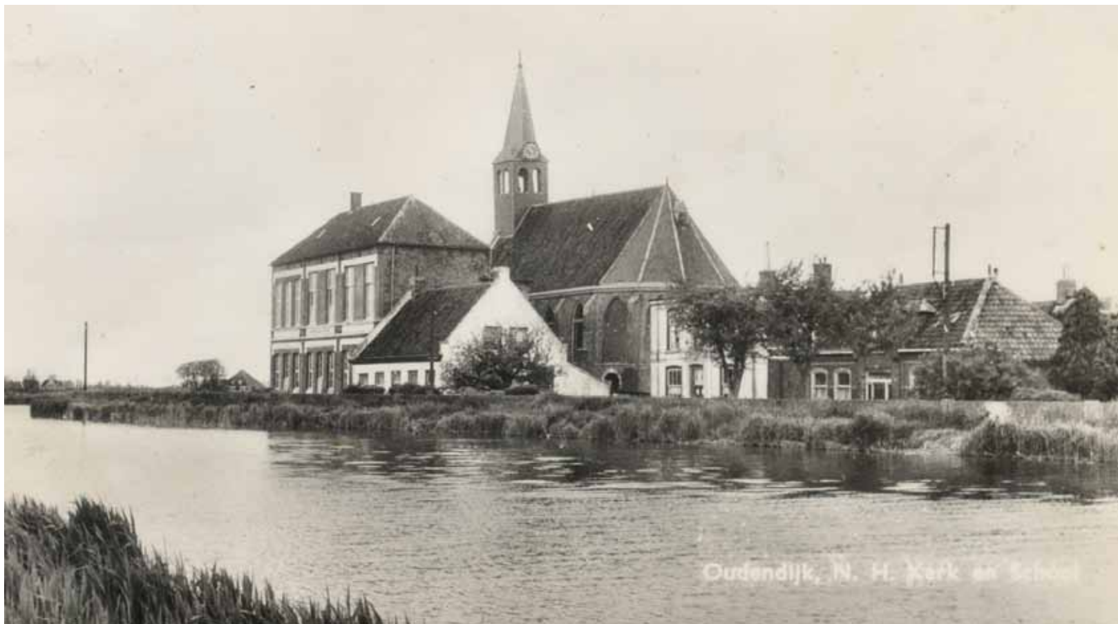
Situatie van 1946. Het grote gebouw werd op de begane grond als schoolgebouw en op de verdieping als gemeentehuis gebruikt. In het kleine witte huis woonde het hoofd der school, meester Frederik Damen. Het witte huis achter de kerk was de pastorie. Het huis rechts was de burgemeesterswoning.
