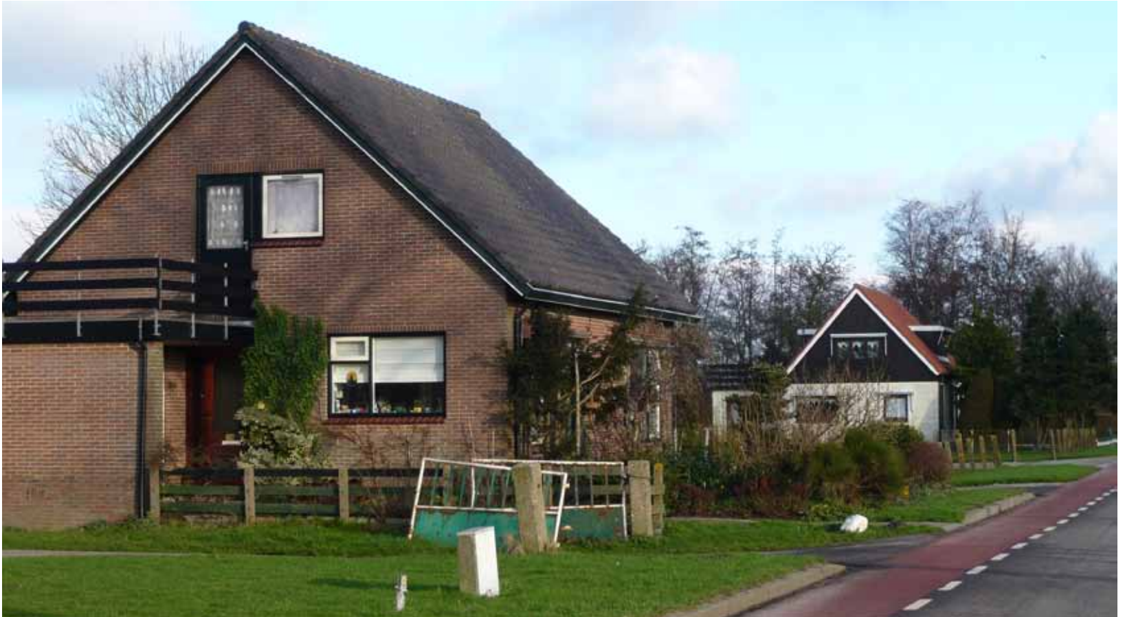
In het linker woonhuis kwamen in maart 1965 Kees Korver en Nel Dekker wonen. In 1975 sloopten zij het oude huis en bouwden op dezelfde plek de huidige woning.
