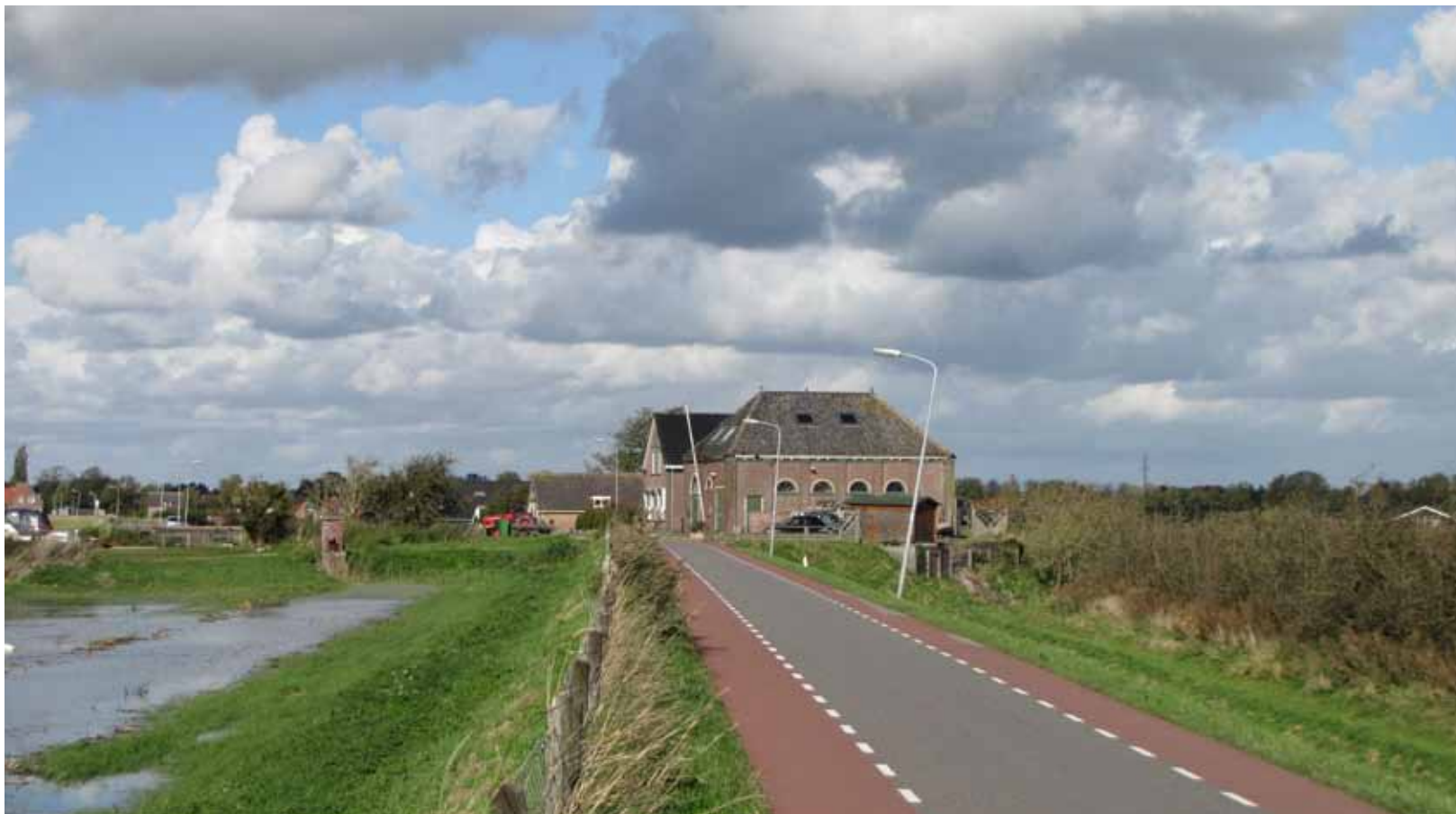
Naast het oude gemaal stond een woning. De fundering daarvan bestond uit sloopmateriaal van een gesloopte molen. In 1996 is de huidige woning neergezet. Het huis en de gebouwen fungeren niet meer als gemaal.
