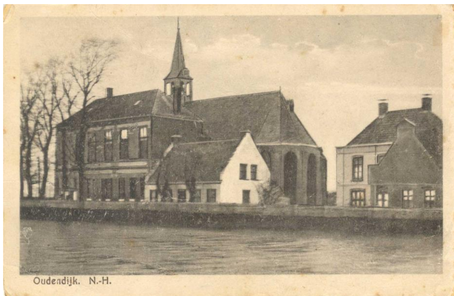
Een kiekje uit 1927. In het meest linker gebouw was de school beneden en het gemeentehuis boven.
