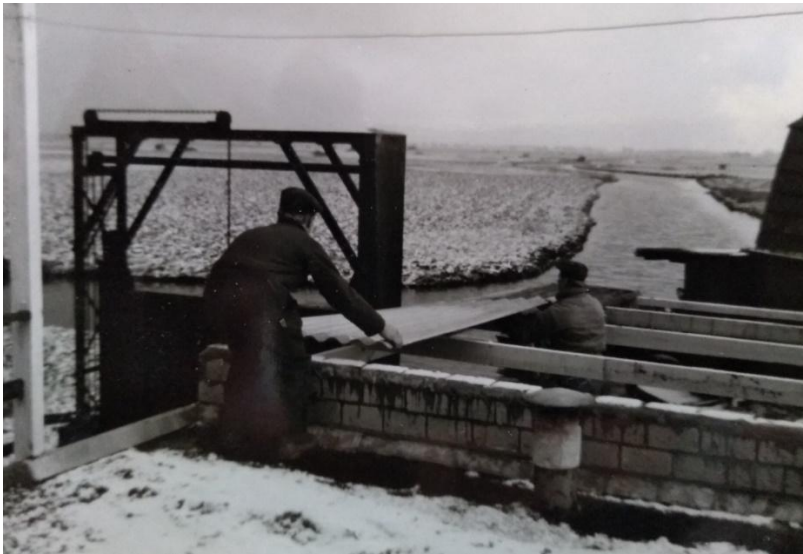
Figuur 7 Sluisdeur aan de Westerkogge met de Naamsloot. Cees Pronk bouwt een schuur met Aad Snoek, winter 1964.
