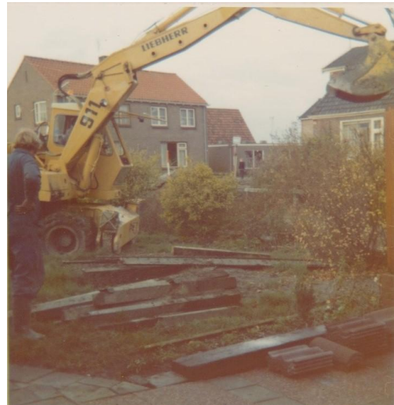
Sloop van de sluis 1976.
